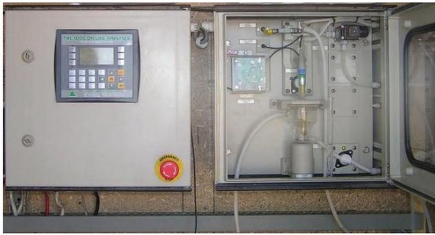
Figure 5. TAC on-line cyanide titrator
